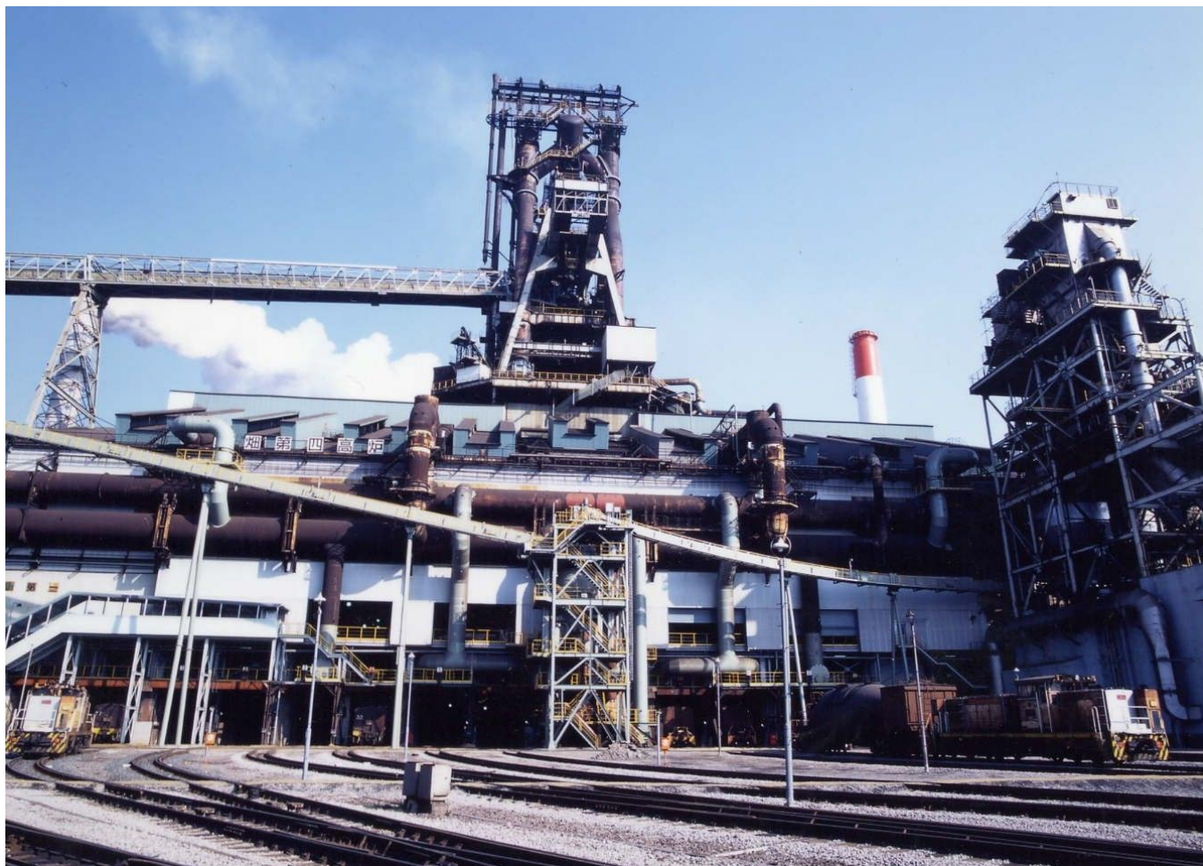
改修工事を行なう 戸畑第四高炉
